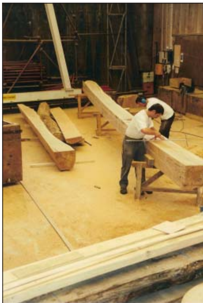
La construction de l'Hermione
