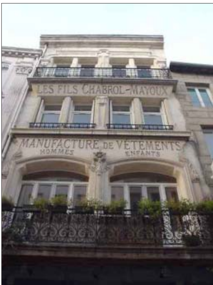
Ancienne manufacture de vêtements
